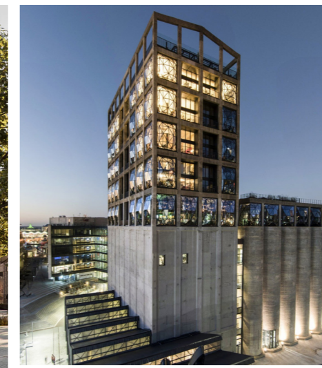
De Silo - transformatie van een bestaande silo
