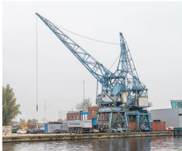
Een overslagkraan op de locatie van het Havenpark
