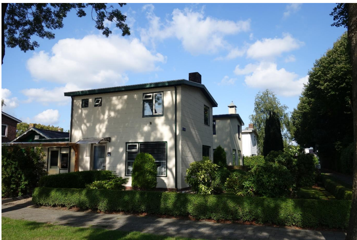
Figuur 39. Aan het Kruispad in Ten Boer staan markante betonsysteembouwwoningen uit 1962; ze zijn typerend voor de technische experimenten in de naoorlogse woningbouw (foto: CeesJan Frank, 10 september 2019).
